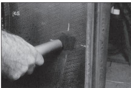
**10** Очистите пылесосом обработанную область для удаления металлической стружки, мелких частиц резины и резиновой пыли.
