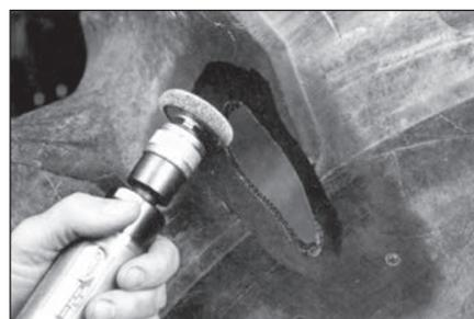
**14** Обработайте края повреждения под углом 45°, используя шероховальный круг RH308 с зернистостью (230 SSG) на низкооборотной дрели (максимальная скорость вращения 4000 об/мин). Это нужно для получения нужной текстуры резины в месте повреждения.
