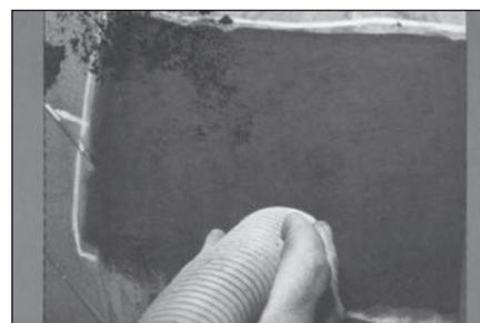
**42** Очистите пылесосом обработанную область для удаления металлической стружки и мелких частиц резины.
