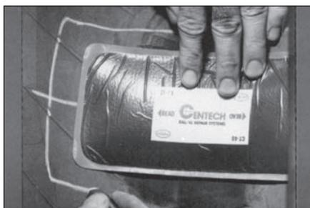
**37** Используя нарисованные вами линии (см. пункт 2), приложите заплату, выбранную ранее (см. пункт 19) на повреждение по центру. Обведите периметр заплата восковым маркировочным мелком примерно на 25 мм больше размеров заплата. Это область для механической обработки шероховкой.
