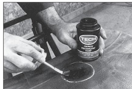
**9** Нанесите тонкий слой клея для химической (холодной) вулканизации №760, двигаясь от центра ремонтируемой области к краям. Не наносите второй (дополнительный) слой клея. Дайте клею примерно 3–4 минуты для того, чтобы он полностью высох.
