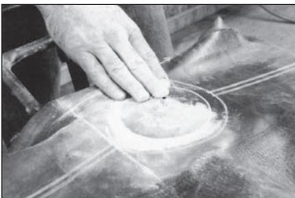
**16** Удалите прозрачную полиэтиленовую пленку с подложки и посыпьте отремонтированное место тальком №706. Это предотвратит прилипание серого слоя подложки к внутренней поверхности шины.
