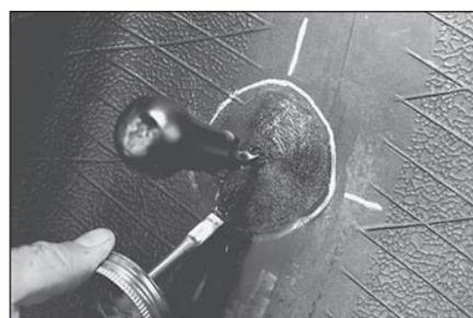
**14** Нанесите клей № 760 для химической вулканизации на обработанную поверхность. Дайте клею примерно 3–4 минуты для того, чтобы он полностью высох. При работе в помещении с высокой влажностью или низкой температурой необходимо вдвое увеличить время высыхания клея.
