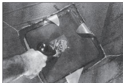
**76** Используя пневмомолоток, прижмите заплата к месту ремонта, а затем прикатайте ее раскаткой, двигаясь от центра к краям.
