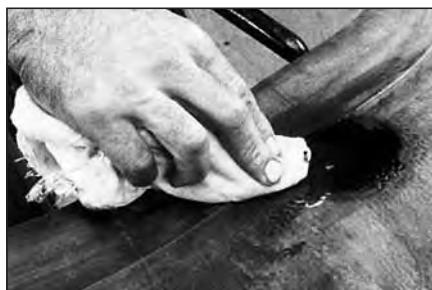
3 Очистите ремонтируемую область с помощью чистящей (обезжиривающей) жидкости №704Е и ткани, не содержащей ворс.
