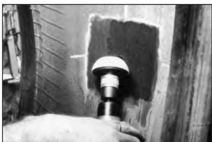
**10** Обработайте отмеченную область абразивной полусферой на пневмодрели. Скорость вращения пневмодрели при обработке не должна превышать 4000 об/мин.
