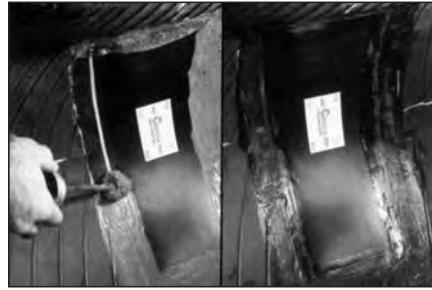
**60** Для бескамерных шин: нанесите серый герметик №738 на края заплаты и зачищенную поверхность за пределами заплаты.
