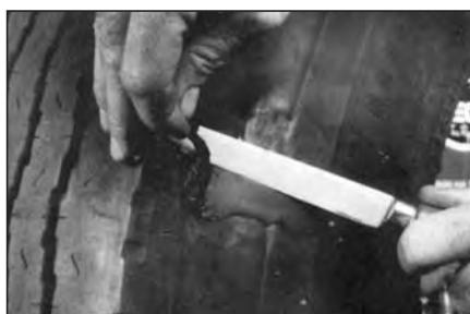
**44** После окончания вулканизации отсоедините линию подачи воздуха и снимите вулканизатор с покрышки. Дайте покрышке остыть, а затем гибким ножом №942 отрежьте остатки непропаренной резины на покрышке.
