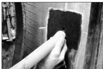
**14** Очистите пылесосом №S999 обработанную область для удаления металлической стружки и резиновой пыли.
