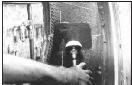
**48** Обработайте отмеченную область мелкозернистой абразивной полу-сферой на низкооборотной дрели до получения ровной шероховатой поверхности. Это нужно для увеличения площади контакта заплаты с покрышкой. При работе всегда пользуйтесь защитными очками №S918.
