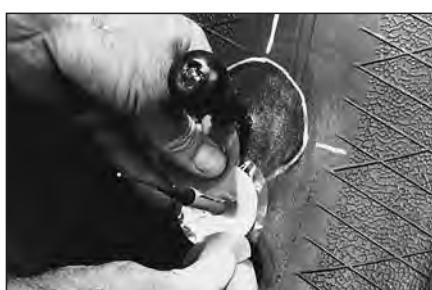
16 Частично снимите синюю защитную пленку со шляпки грибка и освободите серый слой резины. Это позволит брать подложку, не касаясь руками серого слоя резины, а также предотвратит преждевременное приклеивание, пока грибок не будет установлен на место.
