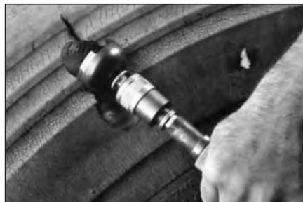
**8** Удалите резину в месте повреждения с внешней стороны покрышки колпачковым обрезателем №S2045, установленными на низкооборотной дрели (максимальная скорость вращения 4000 об/мин).
