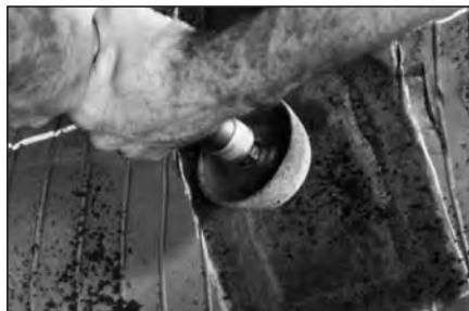
**48** Используя средне- или мелкозернистую полусферу на низкооборотной дрели, обработайте пористый слой резины до получения ровной текстуры. Затем обработайте скос между внешним контуром по периметру заплаты и оставшимся участком заштрихованной области.
