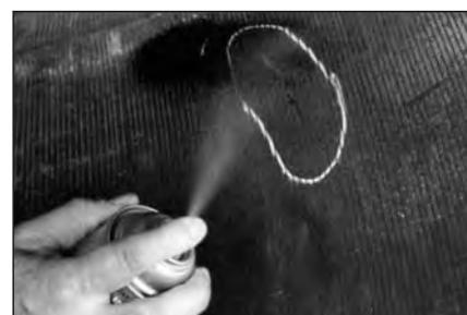
**7** Очистите место повреждения на внутренней поверхности покрышки чистящей жидкостью №704Е с помощью атомайзера (распылителя) №975 .
