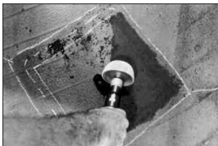
**66** Крупнозернистой полусферой на низкооборотной дрели снимите верхний бутиловый слой резины в пределах внутренней сплошной отмеченной линии. При этом полусфера всегда должна вращаться в одну сторону по поверхности, что предотвратит задирание бутилового слоя резины. Обрабатывайте бутиловый наружный слой резины до тех пор, пока под ним не появится внутренний слой каландровой резины. Вы заметите его появление по изменению цвета. Он более черный.
