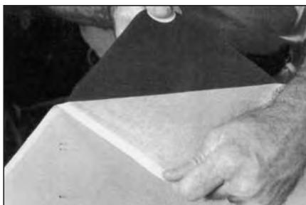
71 Снимите защитное покрытие с заплаты, не касаясь серого слоя во избежание его загрязнения.
