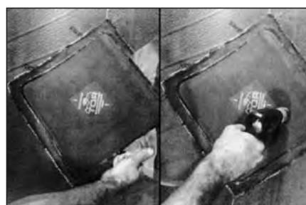
77 Снимая по 50 мм защитного синего покрытия, прокатывайте заплату раскаткой или прибивайте пневмомолотком, пока вся заплата не будет прижата полностью. Если вы используете заплаты для холодной химической вулканизации, снимите сверху прозрачную полиэтиленовую защитную пленку.
