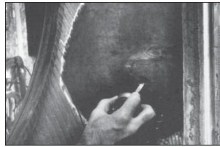
**44** Нанесите слой клея на обработанную поверхность. Дайте клею примерно 3-5 минут для того, чтобы он полностью высох. Если ремонтируемая область камерной покрышки обработана до синтетических нитей корда, нанесите на нее 2 слоя клея и увеличьте время высыхания вдвое.
