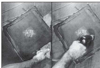
77 Снимая по 50 мм защитного синего покрытия, прокатывайте заплату раскаткой или прибивайте пневмомолотком, пока вся заплата не будет прижата полностью. Если Вы используете заплаты для холодной химической вулканизации, снимите сверху прозрачную полиэтиленовую защитную плёнку.
