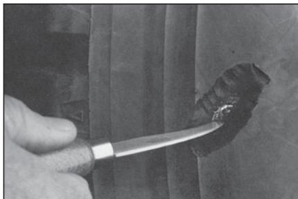
**13** Отделите поврежденные нити металлокорда от резины в месте повреждения с помощью специального ножа № 940.
