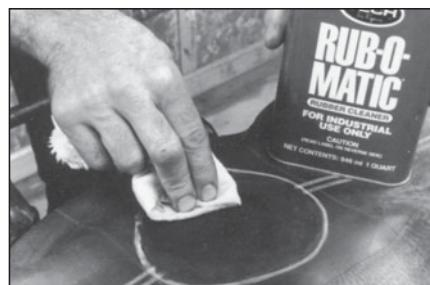
9 После шерохования камеры нанесите обезжирающую (чистящую) жидкость на ткань не содержащую ворса и очистите место повреждения, двигаясь от центра ремонтируемой области к краям. Повторите эту процедуру 2-3 раза. Дайте обезжирающую жидкость 3-4 минуты для того, чтобы полностью высохнуть.
