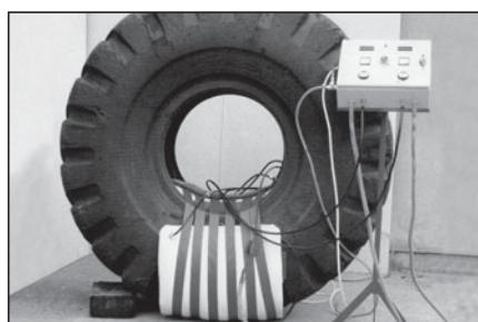
**84** Используя указательные линии, установите вулканизатор по центру повреждения. Подключите вулканизатор в соответствии с рекомендациями производителя.
