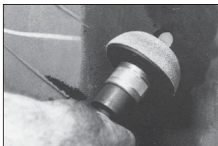
**20** Обработайте покрышку с внутренней стороны вокруг повреждения по периметру на ширину 40-50 мм абразивной полуферой на низкооборотной пневмодрели № S1036.
