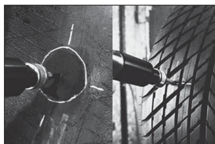
6 Совместите центр грибка с центром повреждения. Обведите шляпку грибка с помощью воскового маркировочного мелка на расстоянии 15 мм. Это будет область для механической обработки покрышки.
