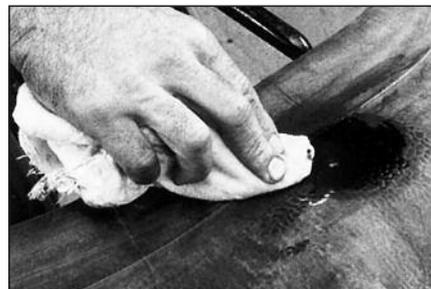
**3** Очистите ремонтируемую область с помощью чистящей (обезжиривающей) жидкости № 704 и ткани, не содержащей ворс.
