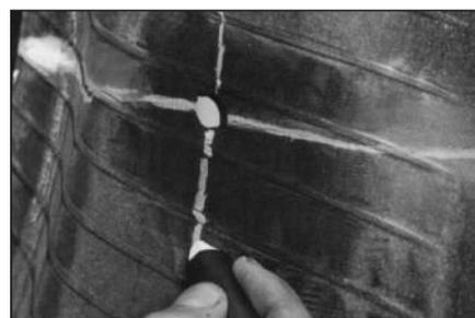
**22** С помощью таблицы по выбору заплат Centech (см. приложение) выберите радиальную заплату на основании размеров повреждения и типа шины.
