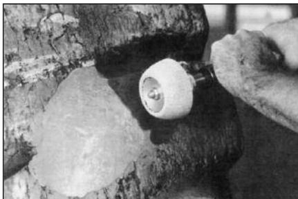
**87** Обработайте место ремонта покрывки снаружи шероховкой на низкооборотной дрели, дойдя до первоначальной поверхности покрывки и следя за тем, чтобы шероховка вращалась в направлении от центра к краям места вулканизации. Это гарантирует, что завулканизированная резина на краях не будет задирается.
