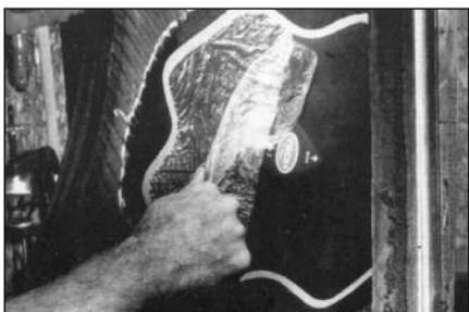
**49** Снимите прозрачную полиэтиленовую пленку с заплаты.
