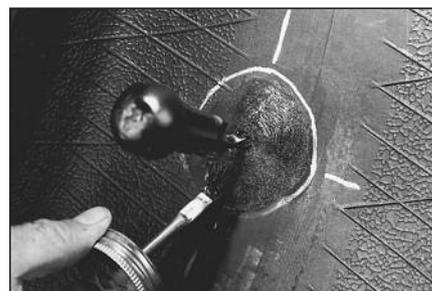
**13** Нанесите клей № 760 для химической вулканизации на обработанную поверхность. Дайте клею примерно 3-4 минуты для того, чтобы он полностью высох. При работе в помещении с высокой влажностью или низкой температурой необходимо вдвое увеличить время высыхания клея.
