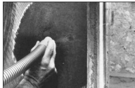
**42** Очистите пылесосом № S999 обработанную область для удаления металлической стружки и мелких частиц резины.
