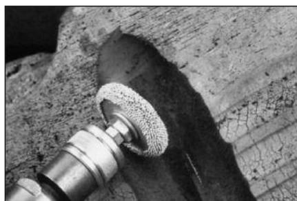
**17** С помощью шероховального кольца на низкооборотной дрели обработайте место повреждения под углом 45° к плоскости повреждения для придания ему формы воронки. Не допускайте контакта абразивного инструмента с металлическим кордом.
