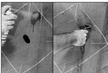
**63** Очистите обведенную область чистящей жидкостью с помощью атомайзера (распылителя). Пока она еще не высохла, снимите верхний слой скребком № 933. Повторите эту операцию 2-3 раза.
