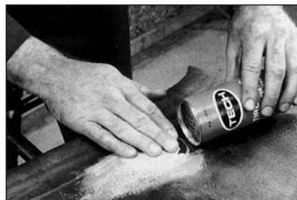
**12** Удалите прозрачную полиэтиленовую пленку с заплаты и посыпьте отремонтированное место тальком № 706. Это предотвратит прилипание серого слоя заплаты к внутренней стороне крышки. После этого камера готова к эксплуатации.
