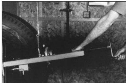
**35** Установите вулканизатор на покрышке так, чтобы нагревательные элементы находились по центру пореза снаружи и изнутри шины.
