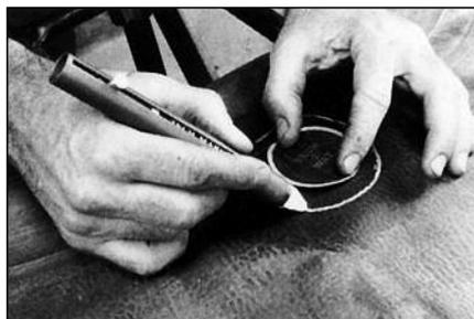
**5** Приложите заплату по центру повреждения и отметьте вокруг нее область на 15 мм больше для механической обработки камеры.
