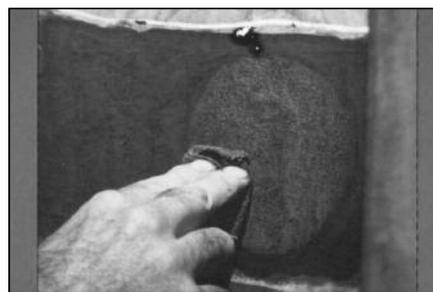
**41** Нанесите чистящую жидкость на ткань не содержащую ворса и очистите место повреждения, двигаясь от центра к краям. Повторите эту процедуру столько раз, сколько требуется для хорошей очистки ремонтируемой поверхности. Дайте чистящей жидкости 3-5 минут, чтобы полностью высохнуть (во влажных условиях время высыхания увеличивается).
