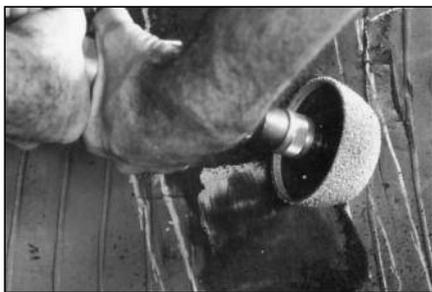
**46** Используя крупнозернистую шероховатую полусферу на низкооборотной дрели, снимите верхний слой резины в пределах заштрихованной области, пока не появится слой пористой резины. Обязательно используйте защитные очки № S918.
