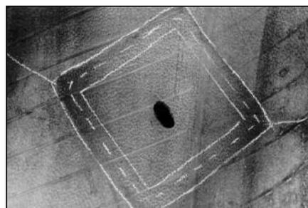
**65** Положите заплату на повреждение и обведите её по периметру пунктирной линией. Снимите заплату и проведите сплошную линию внутри пунктирной линии на расстоянии 25 мм от неё.
