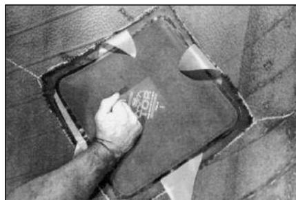
**75** Установите заплата по центру повреждения так, чтобы стрелка, указывающая на борт, действительно была направлена к борту покрышки. Для этого используйте указательные линии (см. пункт 2).
