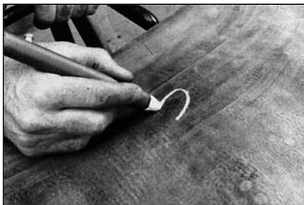
**1** Обозначьте повреждение с помощью воскового маркировочного мелка № 951.
