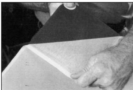
**71** Снимите защитное покрытие с заплата, не касаясь серого слоя во избежание его загрязнения.
