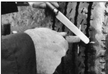
**29** Отрежьте выступающую часть ножки грибка вровень с поверхностью покрышки. Если ножка закрывает канавку рисунка протектора, Вы можете нарезать протектор заново в месте ремонта.
