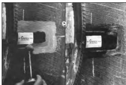
**56** Снимите прозрачную полиэтиленовую пленку с заплаты. При ремонте бескамерной покрышки нанесите герметик заплат №738 по периметру заплаты и на оставшуюся обработанную поверхность. Если вы ремонтируете камерную покрышку, посыпьте отремонтированное место тальком №736. Это предотвратит слипание серого слоя на краях заплаты и камеры.
