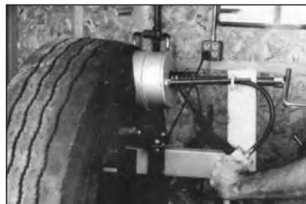
**42** Установите пневмоподжим на вулканизаторе, подсоединив линию подачи воздуха. Подайте давление воздуха не более 2 атм. Если вы используете ручной вулканизатор без пневмоподжима, то вам необходимо снова затянуть его через 5-10 минут после начала процесса вулканизации.
