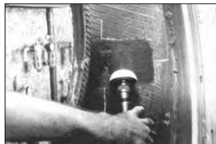
**48** Обработайте отмеченную область мелкозернистой абразивной полусферой на низкооборотной дрели до получения ровной шероховатой поверхности. Это нужно для увеличения площади контакта заплаты с покрышкой. При работе всегда пользуйтесь защитными очками №S918.
