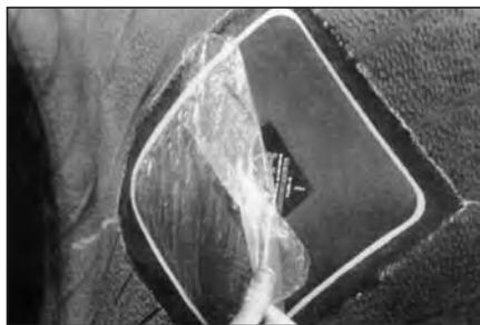
**55** Снимите защитное прозрачное полиэтиленовое покрытие сверху заплата. Проверьте, нет ли воздушных мешков под заплатай. Если они есть, снова прокатайте эти места раскаткой.
