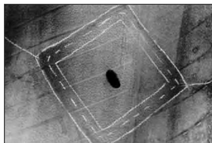
**65** Положите заплатку на повреждение и обведите ее по периметру пунктирной линией. Снимите заплатку и проведите сплошную линию внутри пунктирной линии на расстоянии 25 мм от нее.
