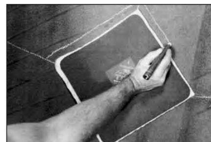
**62** Положите ранее определенную заплата TOR на повреждение и обведите ее по периметру на расстоянии примерно 25 мм от края заплатай. Эта линия является указателем для последующей очистки и шерохования.
