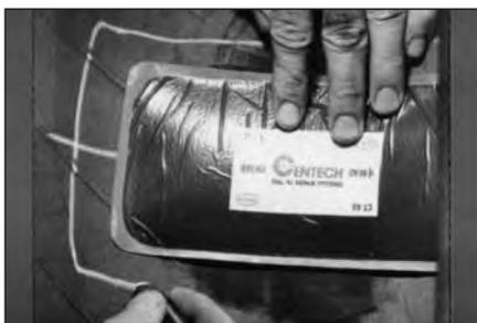
**37** Используя нарисованные вами линии (см. пункт 2), приложите заплату, выбранную ранее (см. пункт 19) на повреждение по центру. Обведите периметр заплаты восковым маркировочным мелком примерно на 25 мм больше размеров заплаты. Это область для механической обработки шероховкой.
