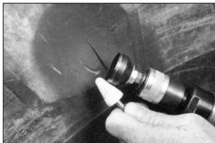
**9** Снимите верхний слой резины по периметру повреждения колпачковым обрезателем № S2045, установленным на низкооборотной дрели (максимальная скорость вращения 5000 об/мин). Затачивайте колпачковый обрезатель перед каждым применением.
