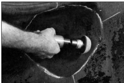
**44** Обработайте отмеченную область до ровной поверхности мелкозернистой абразивной полусферой на низкооборотной дрели со скоростью вращения не более 5000 об/мин. Это необходимо для увеличения площади соприкосновения заплаты с покрышкой.
