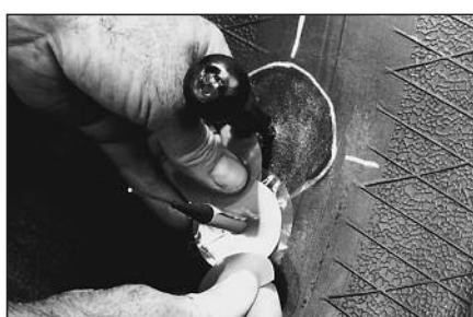
**15** Частично снимите синюю защитную пленку со шляпки грибка и освободите серый слой резины. Это позволит брать подложку, не касаясь руками серого слоя резины, а также предотвратит преждевременное приклеивание, пока грибок не будет установлен на место.
