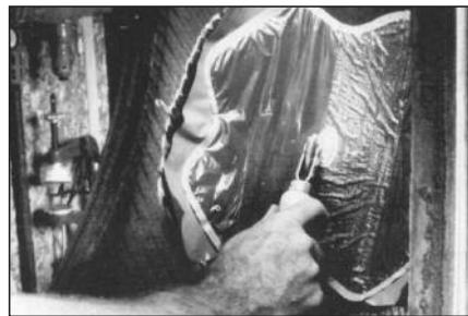
**47** Тщательно прикатайте заплату раскаткой № 936 от центра к краям. Надавите на раскатку для обеспечения более плотного контакта заплаты и покрышки.
