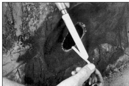
**60** Далее до пункта 88 идет описание ремонта одноэтапным методом в вулканизационной камере или с применением вулканизатора Монафлекс. Измерьте максимальную глубину повреждения, чтобы рассчитать время вулканизации. Расчет времени вулканизации не может быть закончен, пока повреждение не будет заполнено.
