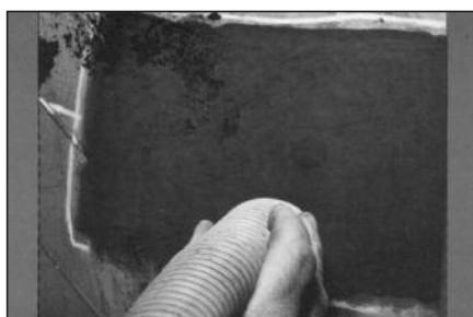
**40** Очистите пылесосом № S999 обработанную область для удаления металлической стружки и мелких частиц резины.
