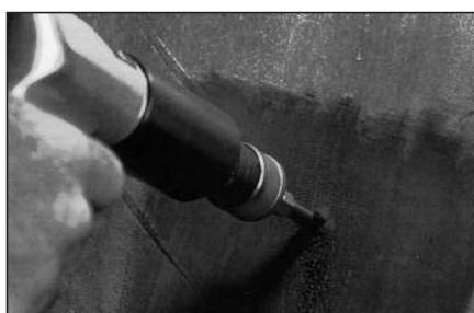
8 Подготовьте повреждение с помощью карбидной фрезы. Скорость вращения дрели при этом не должна превышать 1200 об/мин. Используйте вращение по часовой стрелке. Обработайте прокол с внутренней стороны покрышки. Повторите эту процедуру три раза для того, чтобы обеспечить необходимую подготовку поврежденного места.
