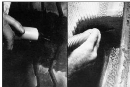
20 Очистите пылесосом № S999 обработанную область, чтобы удалить частицы резины с внутренней и внешней стороны покрышки.
